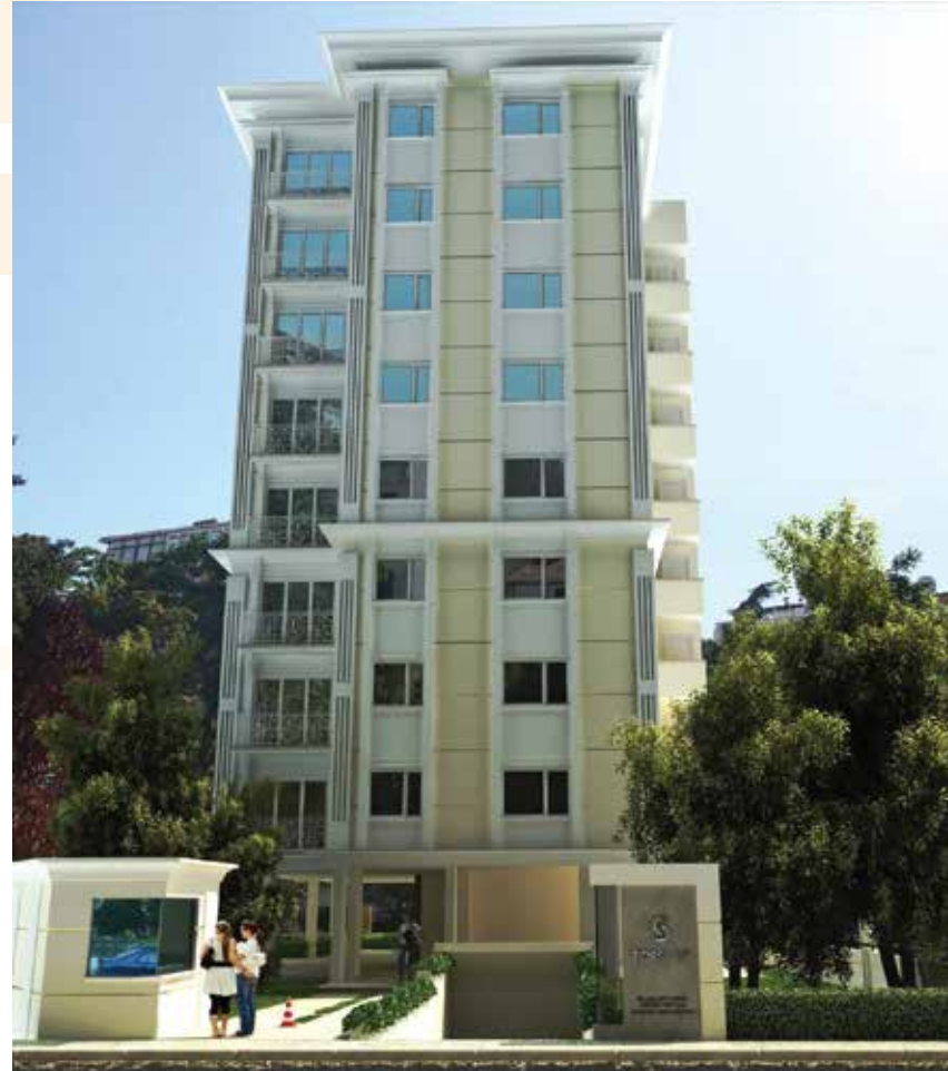
Sevgili İnşaat | Forsa Projesi
