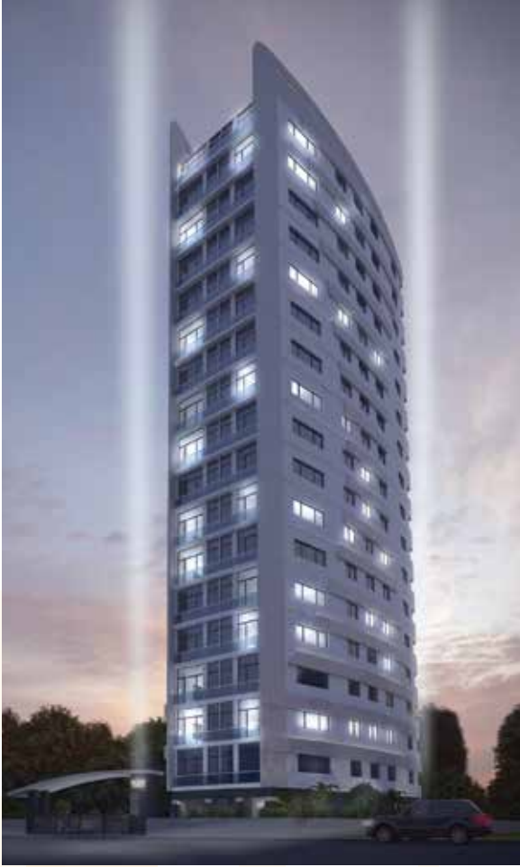
Koç Yapı | Akasya Tower Projesi
